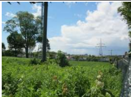
Fot. 5. Napowietrzna elektroenergetyczna linia WN-110 kV przebiegająca przez północną część obszaru opracowania
