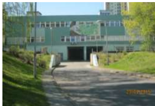
Fot. 8. Osiedlowy Dom Kultury „Orle Gniazdo” (teren 3U)
