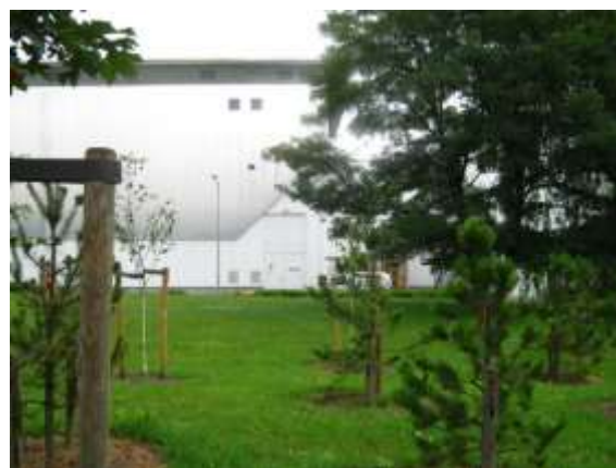
Fot.6. Magazyn wysokiego składowania.
