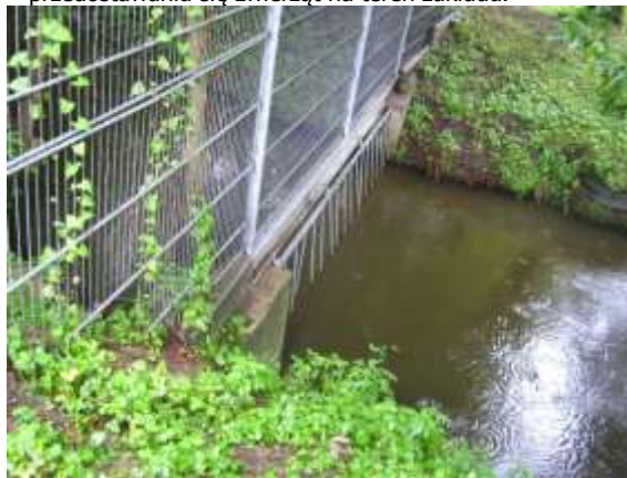
Fot. 14. Zabezpieczenia na rzece Głównej zapobiegające przedostawaniu się zwierząt na teren zakładu.
